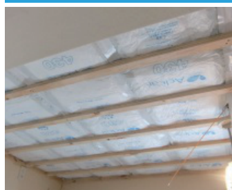
床・外壁・屋根の断熱改修
